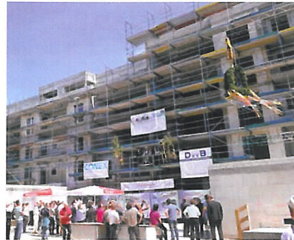
Über dem Rohbau des neuen Heidekamp-Ecks ging der Richtkranz hoch.
